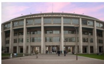
Proyecto: Conservación Tribunales Administración Zonal Concepción Subproyectos: ICA de Concepción y otros Fecha estimada de término : 2° semestre 2023 Inversión 2023 : M$ 1.110.555 Inversión Total : M$ 4.713.232
