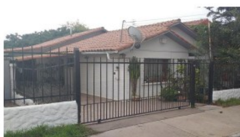
Proyecto: Conservación Viviendas Judiciales Subproyectos: no aplica Fecha estimada de término : 2° semestre 2023 Inversión 2023 : M$ 265.750 Inversión Total : M$ 3.117.190
