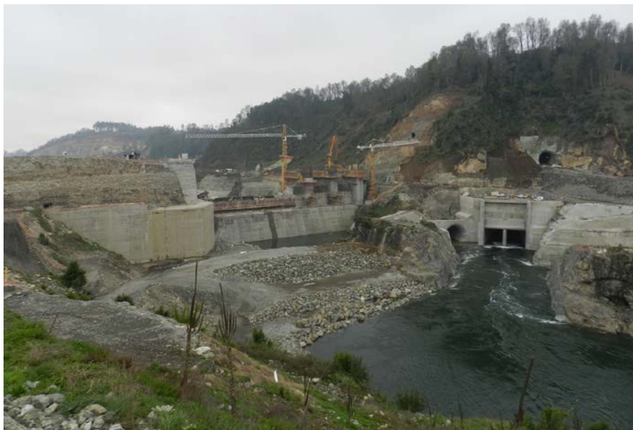
Vista del muro durante construcción (se observa desvío del cauce)
