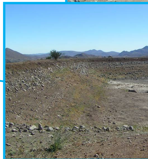
Vista del talud interior del muro
