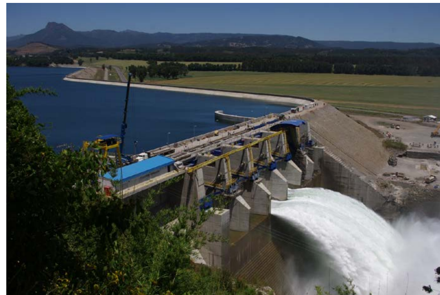
Vista del embalse lleno durante puesta en carga (Imagen de Colbún S.A.)
