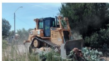
► EXTRACCIÓN DE COMBUSTIBLE
